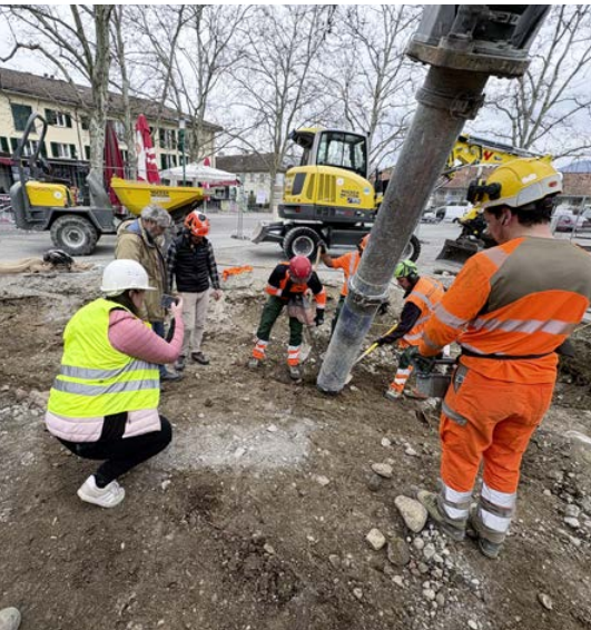
Camion aspirateur retirant avec précaution la terre compacte entre les racines
