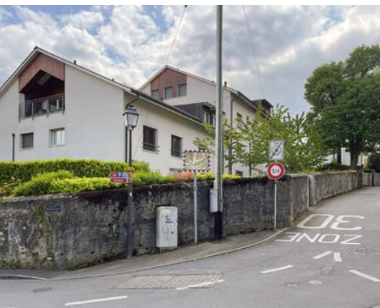
Rampe de Chavant: configuration étroite, contrainte par d'anciens murs en pierre limitant les possibilités d'élargissement
