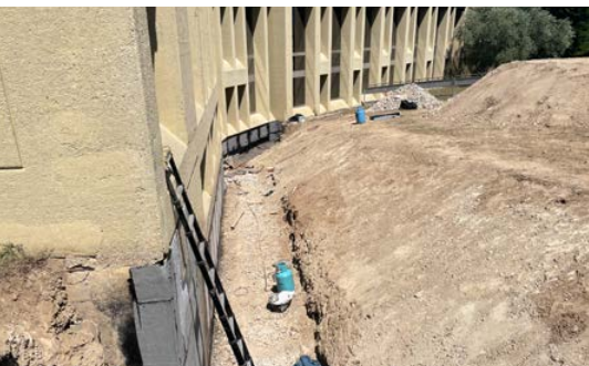
Remplacement partiel de l'étanchéité en pied de façade à l'École de Confignon
