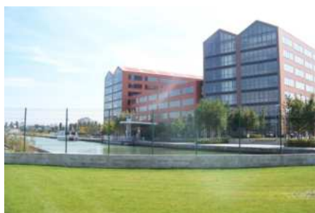
Parc d'activités Le Millenaire, Aubervilliers, France
