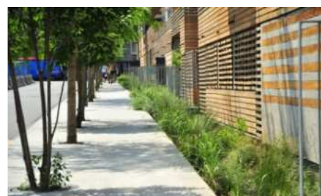
Façade en retrait et récolte des eaux : Le bois habité, François Leclercq, Architectes Urbanistes, Lille, France
