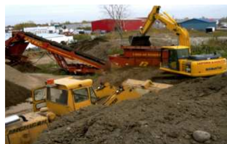
Modelage du sol et valorisation des matériaux d'excavation
