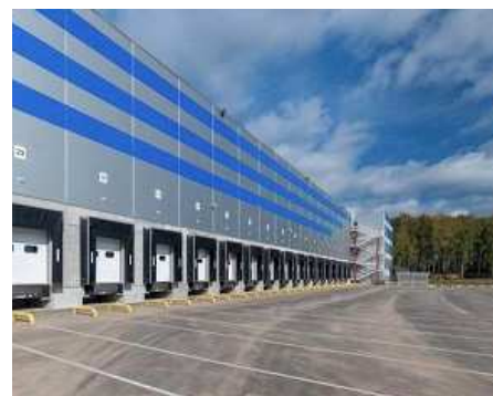
Zone de manœuvre et stationnement camions
