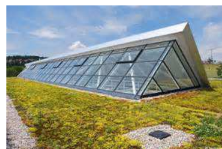
Rétention en toiture
