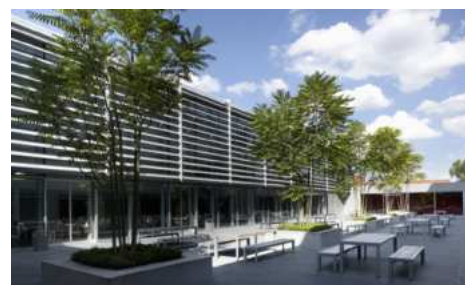
Façade vers les placettes publiques, Telindus Haasrode / Crepain Binst Architecture, Belgique
