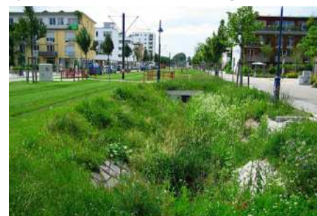
Assainissement des eaux pluviales : noue
