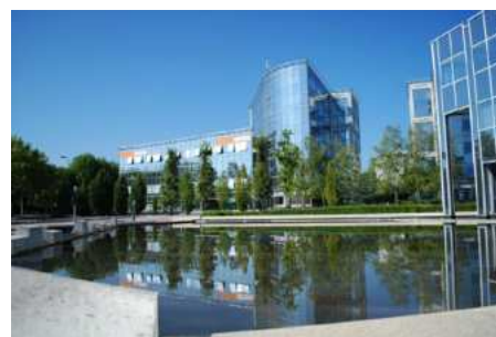
Clôture végétalisée et bassin d'eau, zone d'activités, Paris Nord
