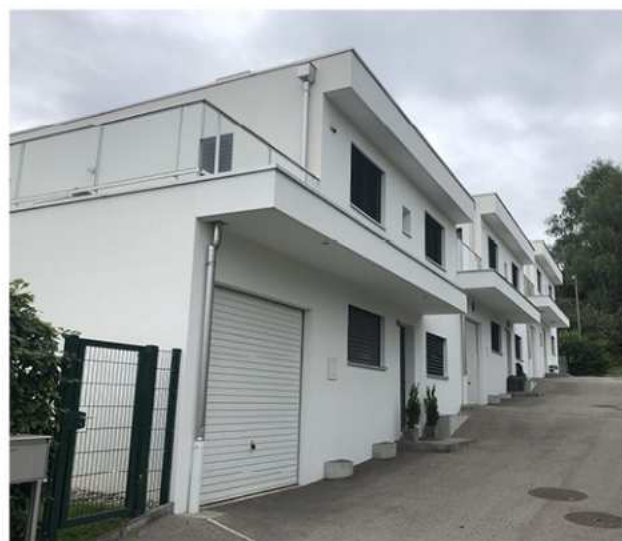
Construction récente (Soral 10) sans arborisation
