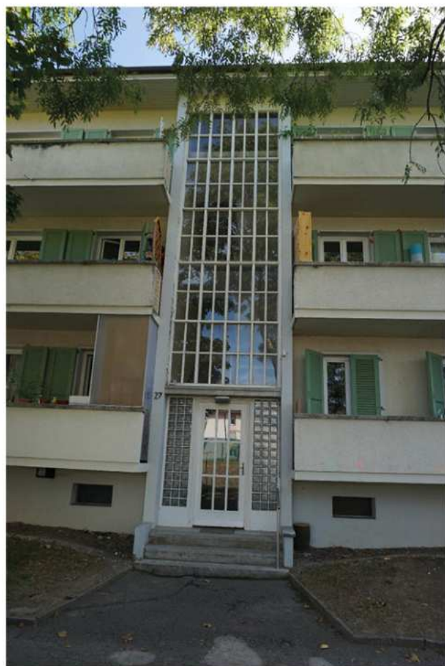
Immeuble à logements - Chemin des Hutins 31, entrée principale, photographie, Aline Jeandrevin pour l'OPS
