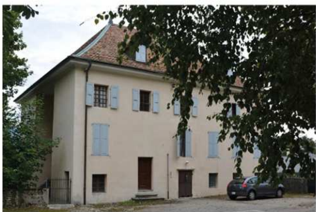
Maison de maître et orangerie - Chemin Pontverre 17, photographie, Gilles Brodard pour l'OPS
