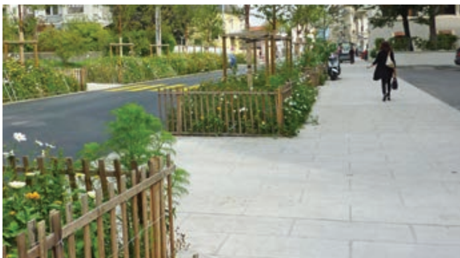
Trottoir en béton clair et route en enrobé
