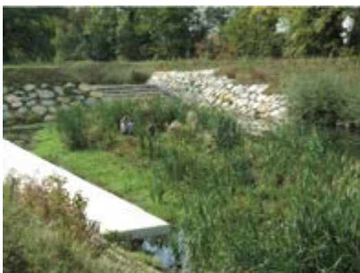
Exemple d'un bassin de rétention paysager
