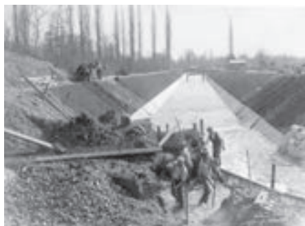
Travaux de correction de l'Aire
