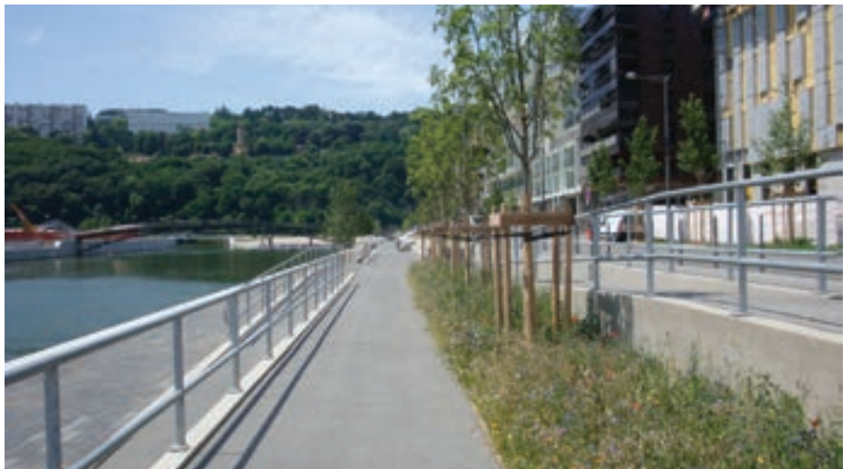
Bande plantée - Place nautique Lyon - France
