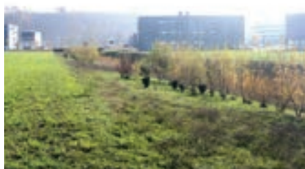
Bassin de rétention
