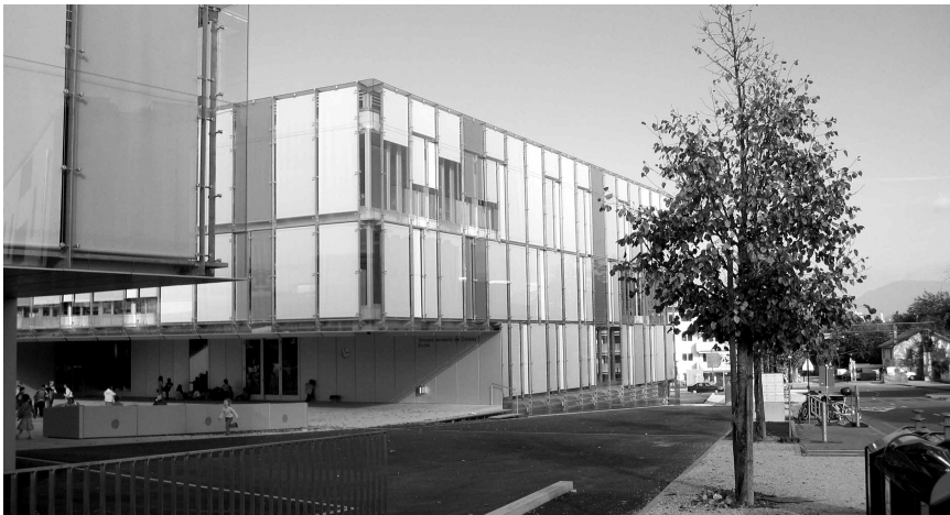
La nouvelle école de Cressy économise l'énergie par sa façade à double peau (Photo Mairie de Confignon)
