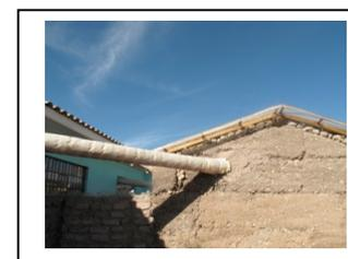
Photo 9: Isolation des tubes à réparer à Santa Rosa
