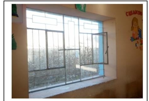
Photo 2: Double vitrage des fenêtres à Achipampa
